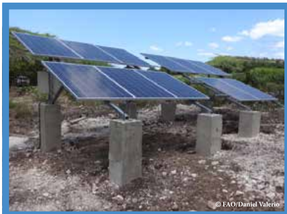
Sistema de agua subterránea instalado para funcionar con energía solar
