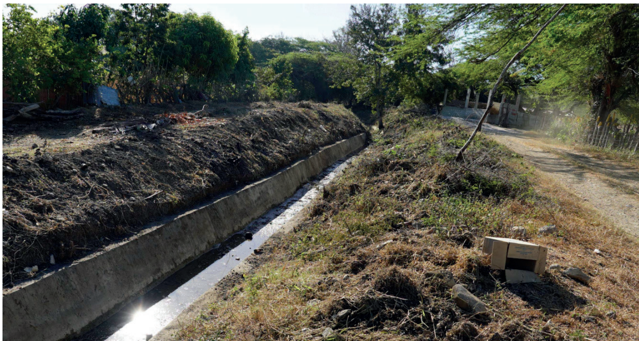
Foto: Presidencia de la República Dominicana. Dique en El Llano construido por el INDRHI en el canal de riego Reboso.
