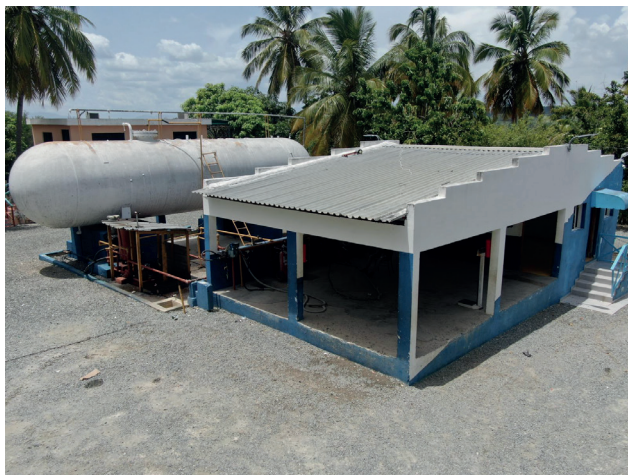
Estación de gas Santa Teresa ubicada en la Carretera Sánchez, Km 2 en la entrada a Elías Piña
