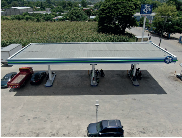
Estación Eco Petróleo ubicada en la Carretera Sánchez, zona comercial Carrizal frente a la estación Elías Piña Gas.
