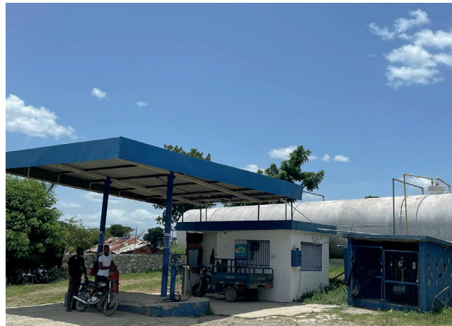
Estación de gas propano Rafa Gas, ubicada en el sector de Villa Hortencia.
